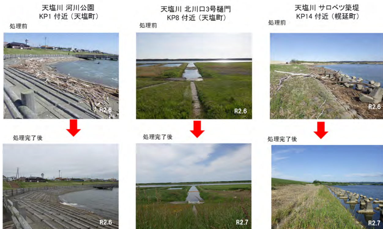
写真- 11 令和2年 融雪出水後の流木・塵芥処理の状況（処理前、処理完了後）
