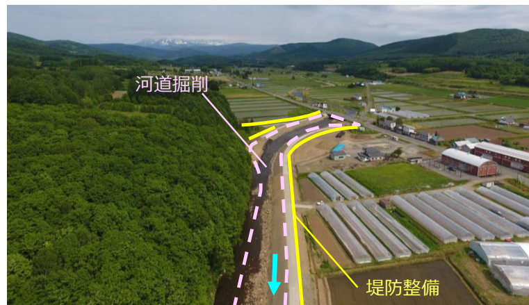
ペーバン川 施工済み箇所
