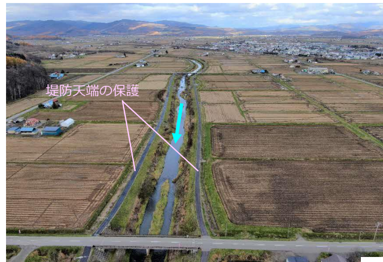
比布川 施工済み箇所
