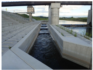
西神楽第1頭首工魚道(旭川市)
