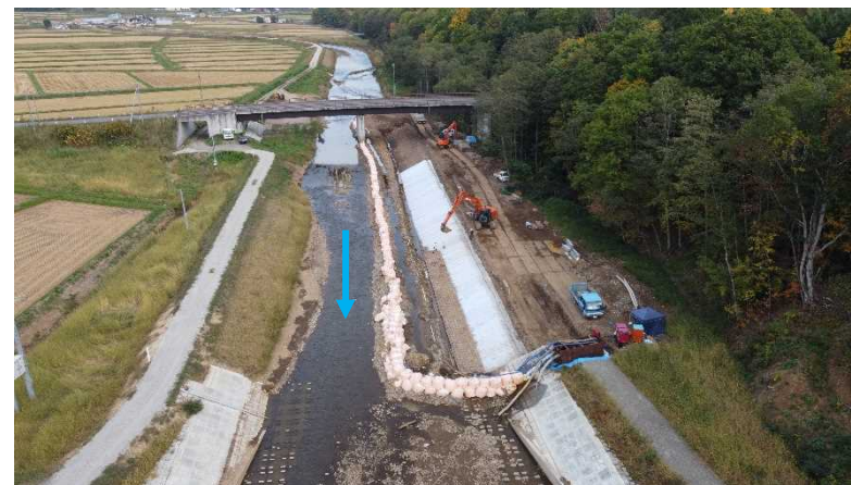
ペーパン川 施工済み箇所
