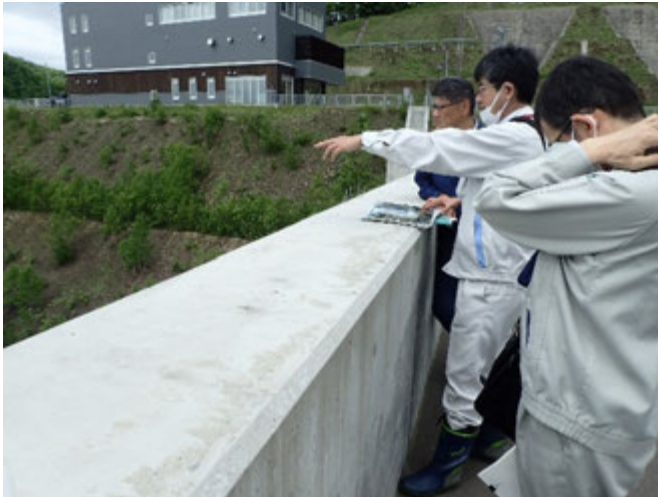
(6/2) ダム堤体 階段式魚道確認
