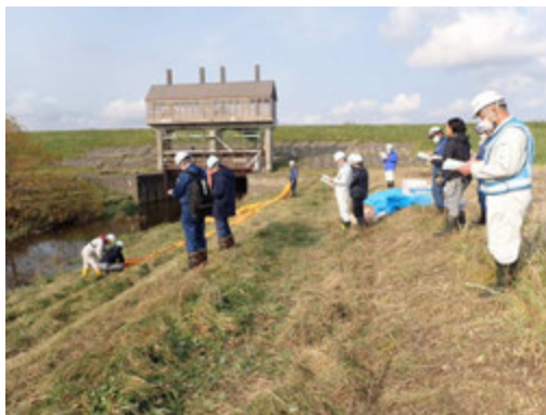
オイルフェンスの展張訓練状況
