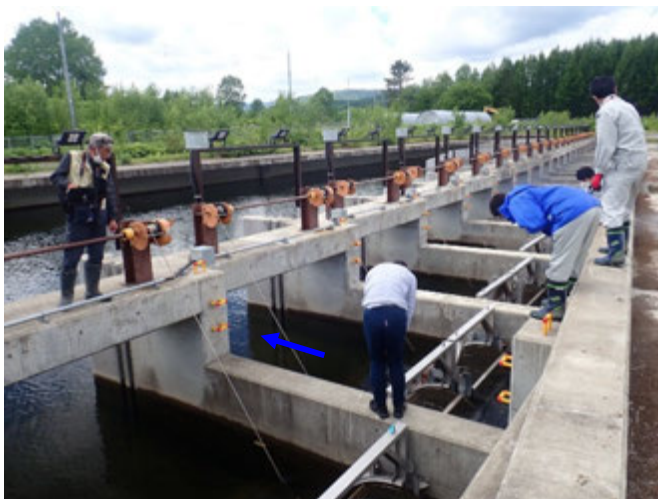
(6/5) 本川との接続箇所 ドラムスクリーン周辺の幼魚遊泳状況確認
