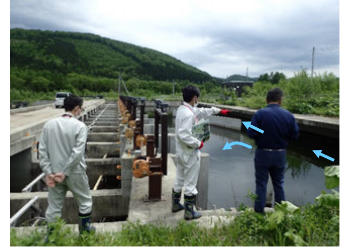
(6/2) 本川との接続箇所 施設内流況確認
