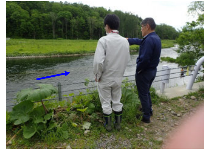
(6/2) ダム堤体下流 流況確認
