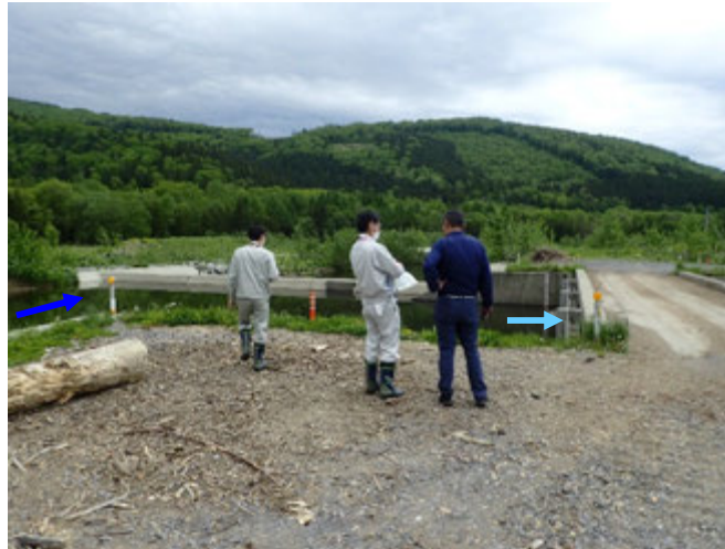
(6/2) 本川との接続箇所 流入部流況確認
