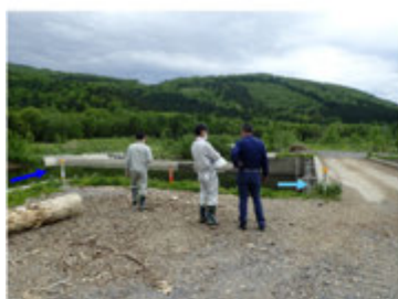
(6/2) 本川との接続箇所 流入部流況確認
