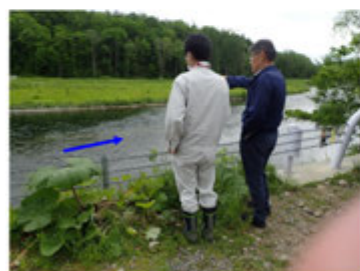
(6/2) ダム堤体下流 流況確認
