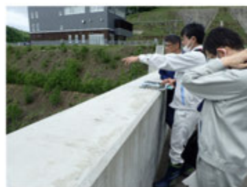
(6/2) ダム堤体 階段式魚道確認
