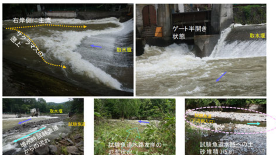
写真-2 取水堰下流の流況と土砂堆積、試験魚道の状況（令和5年8月）
