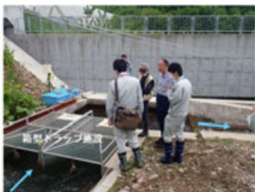
(6/5) 階段式魚道 スモルト採捕状況確認
