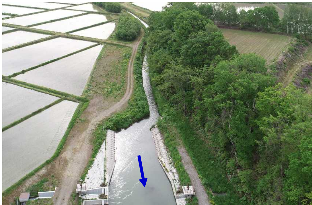
○ポン川(掘削工・築堤工予定)
