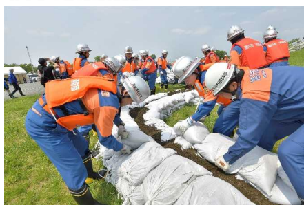
水防工法訓練
