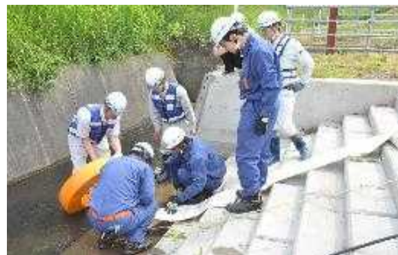
水防訓練(釜場排水ポンプ設置)
