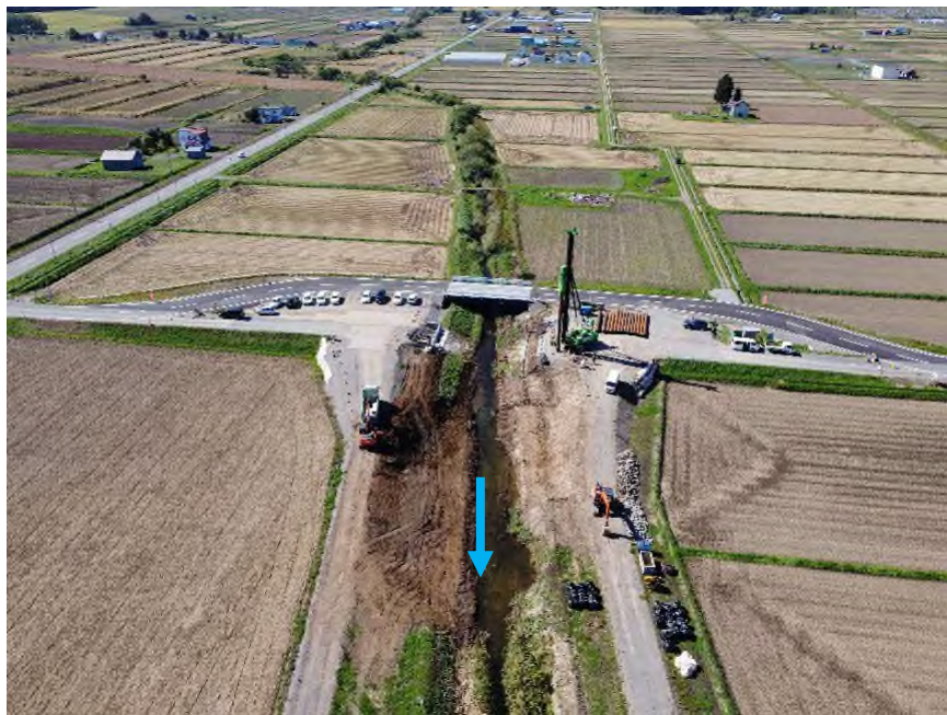
剣淵川(和寒町) 施工箇所(河川)
