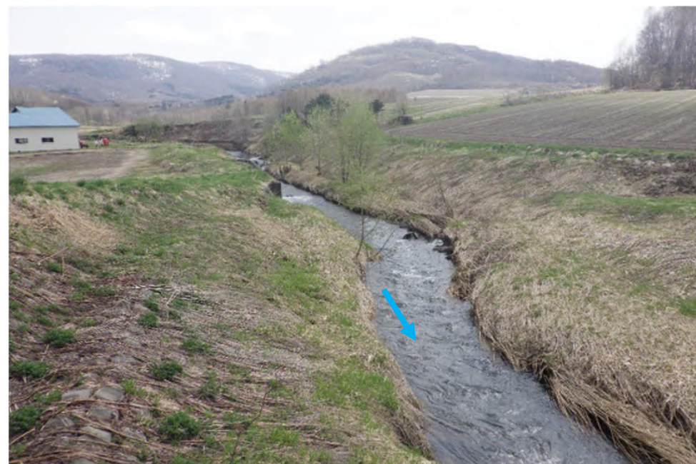
マタルクシュケネブチ川(和寒町) 施工箇所(河川)
