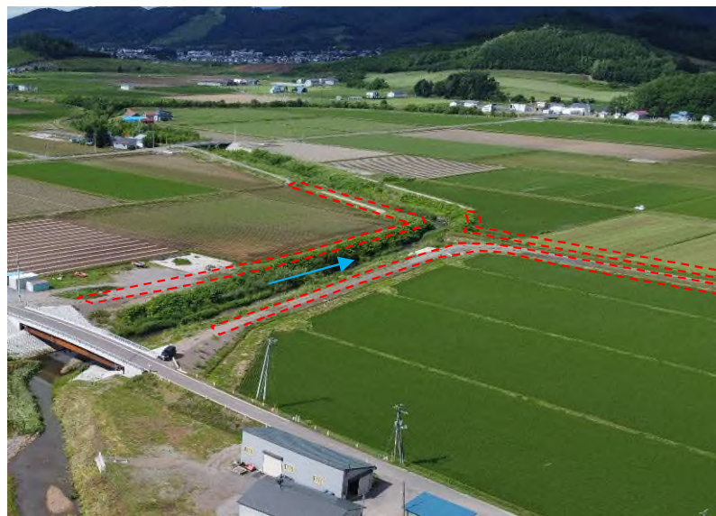
剣淵川(和寒町) 施工予定箇所(河川)
