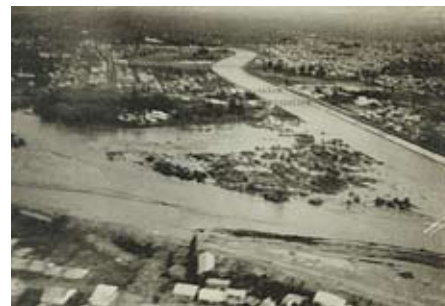
現石狩川合流点付近 切りかえ工事後
