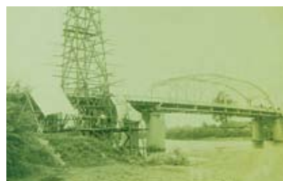
旧旭橋の取り壊し(昭和2年頃) 写真:旭川市中央図書館
