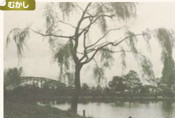
昭和15年(1940)頃 常磐公園と旭橋
