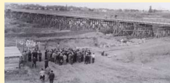
昭和30年(1955)以前 石狩川 金星橋
