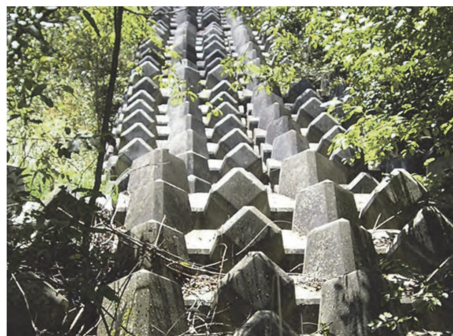
たくさんのブロックを積み重ねて造った富良野川2号ブロックダム
