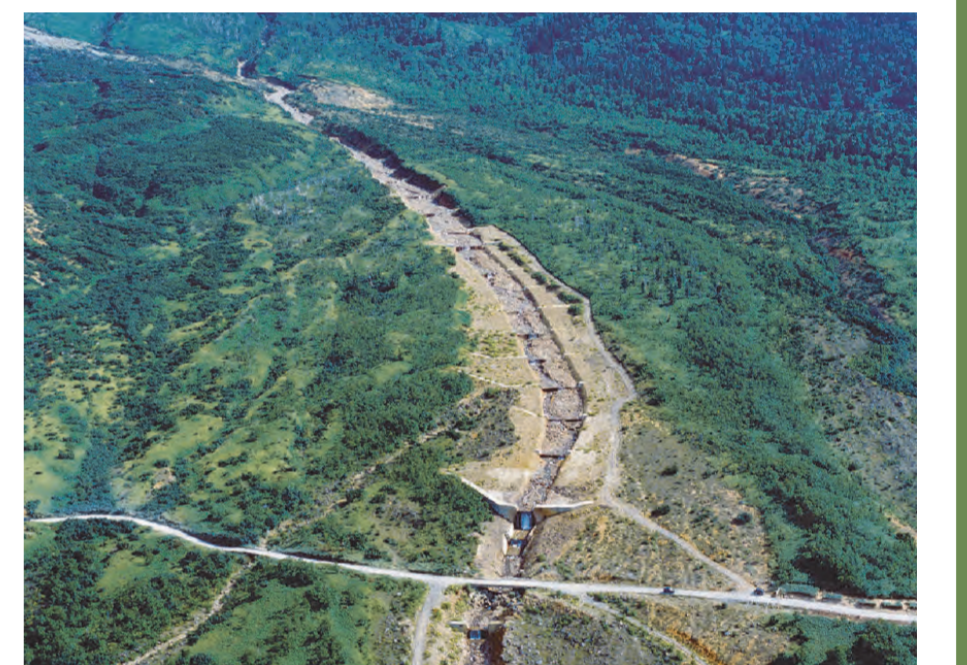
富良野川上流にたくさん造られた、侵食を防ぐための床固工
