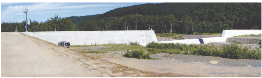
美瑛川第5号砂防えん堤
