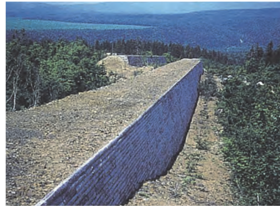
美瑛川支流の硫黄沢に造られた導流堤
