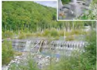
美瑛川ブロックえん堤(平成17年撮影)
