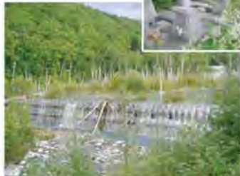
美瑛川ブロックえん堤(平成17年撮影)
