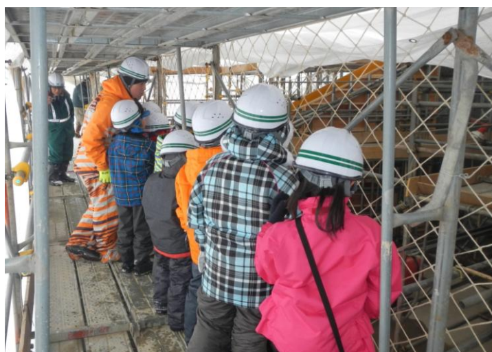
足場から樋門工事の説明を聞きます
