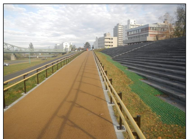
天端と河川敷をつなぐ通路
