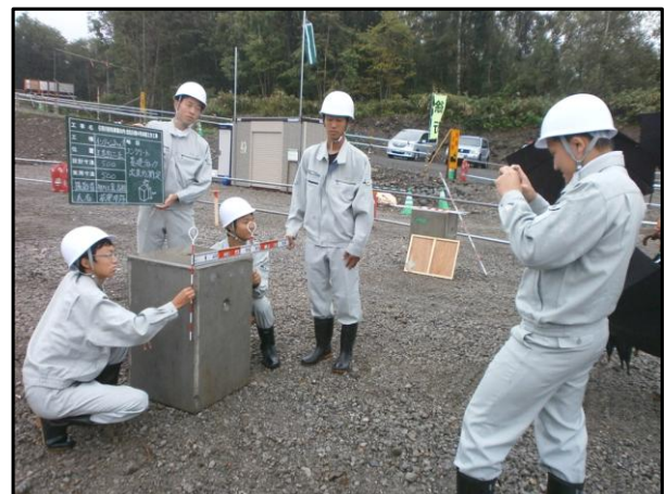
工事現場で品質管理を体験する生徒たち
