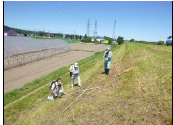
職員による堤防点検状況
