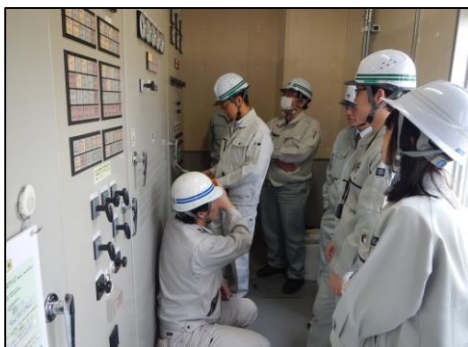
神居川水門操作訓練状況
