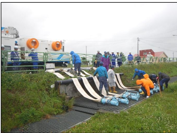
排水ポンプ車設置訓練状況
