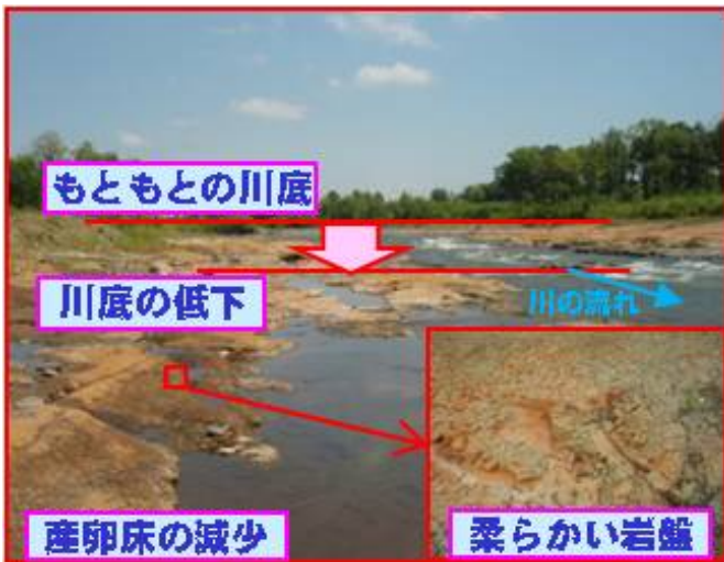
北旭川大橋下流付近の状況
