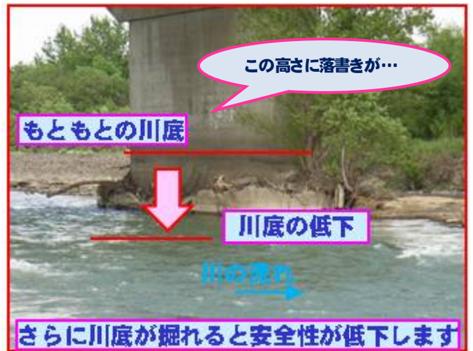
秋月橋左岸橋脚付近の状況
