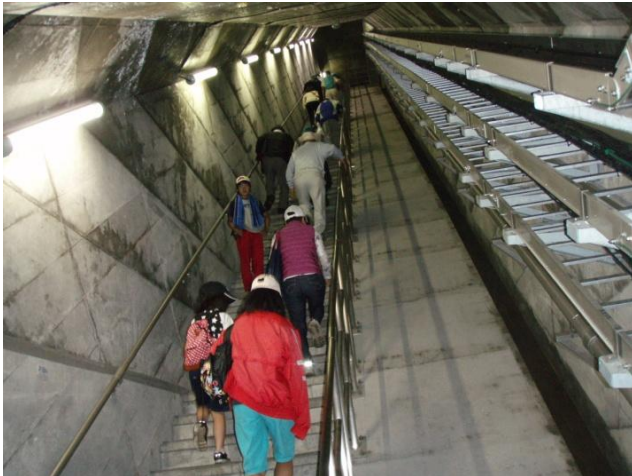
監査廊を歩いてダム堤体内部探検
