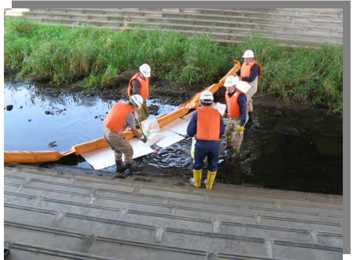
オイルフェンス・オイルマット設置状況
