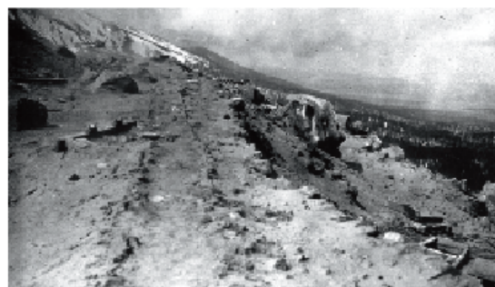
大正噴火で崩れた土砂におそわれ、建物がバラバラに壊れた 鉱山の作業小屋の跡(東京大学・多田文男教授(当時)撮影)
