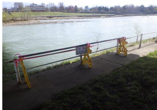
危険表示状況
