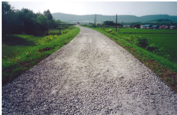
堤防天端補修後
