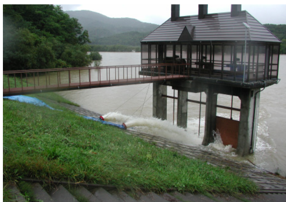
排水ポンプ車による排水
