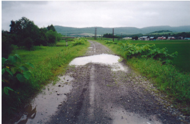
堤防天端補修前
