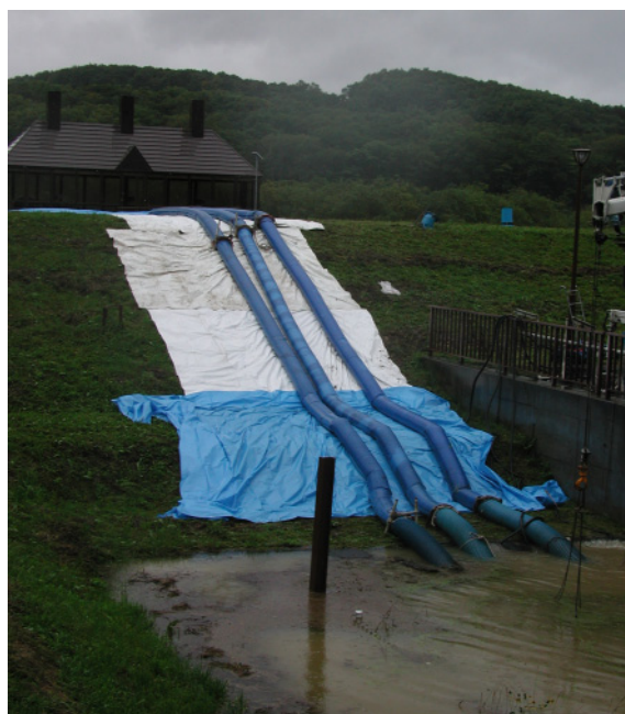
排水ポンプ車による排水
