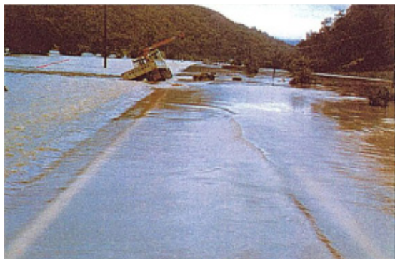
天塩川右岸 箴島左岸築堤の溢水氾濫状況 (音威子府村)
