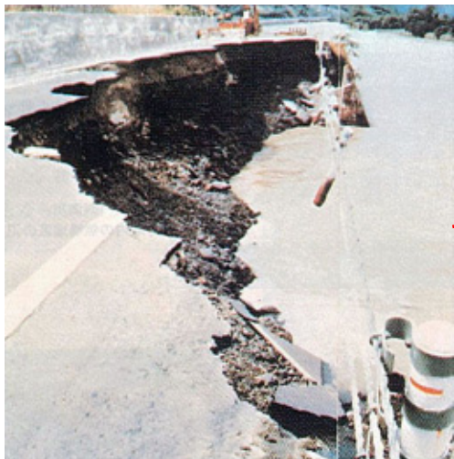
天塩川左岸 国道40号線の決壊状況 (中川町富和地先)
