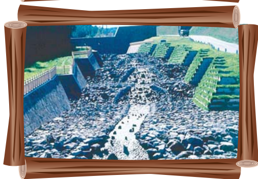
1990～1995年にかけて造られた 十勝岳流路工
