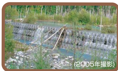
美瑛川ブロックえん堤 （2007年以前の様子）
