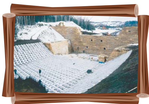
1989～1990年 にかけて造られた 尻無沢川第2号 砂防えん堤（建設 中の様子）
