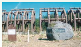
富良野川の中流につく 造られた富良野川 2号透過型ダム
