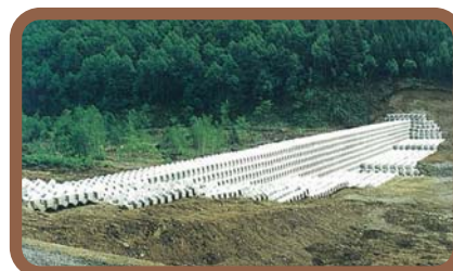
富良野川1号ブロックえん堤 （完成直後の様子）
