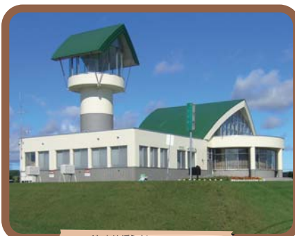
草分防災センター
