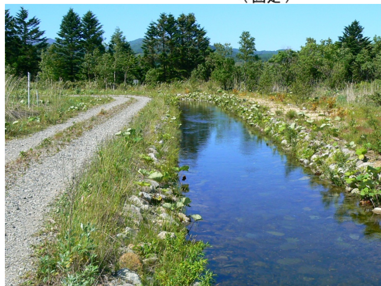
素掘り水路による魚道の類似事例
