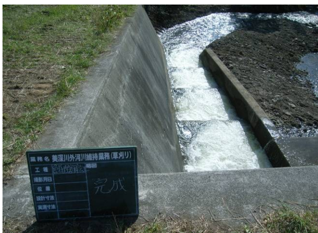
埋塞土砂撤去後の状況
