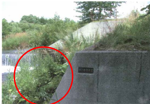
魚道部の土砂埋塞状況
