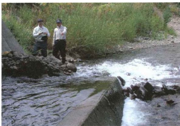
一部土砂撤去後の状況
