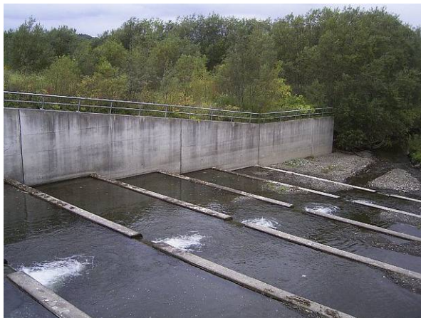
流木撤去後の状況
