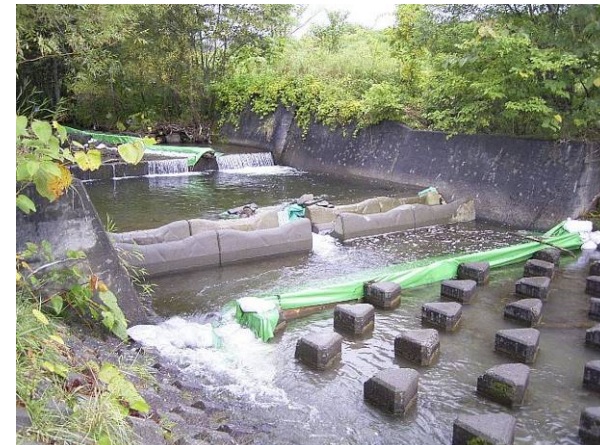
遡上水深を確保する仮設措置 (措置後にサケの遡上確認)
