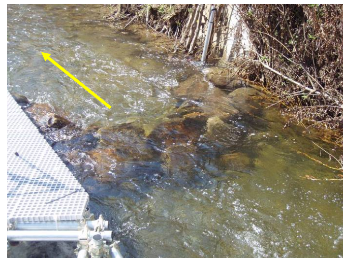
魚道下流石組み状況
