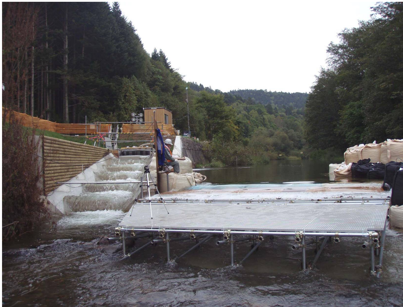
調査用魚道(魚道入口部・迷入防止施設)
