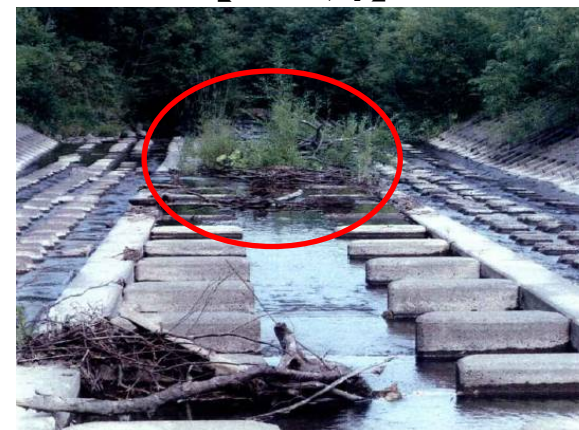
魚道部の土砂埋塞状況
