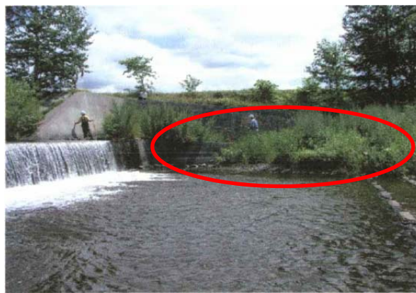
魚道部の土砂埋塞状況
