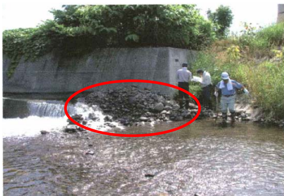
魚道入口部の土砂堆積状況
