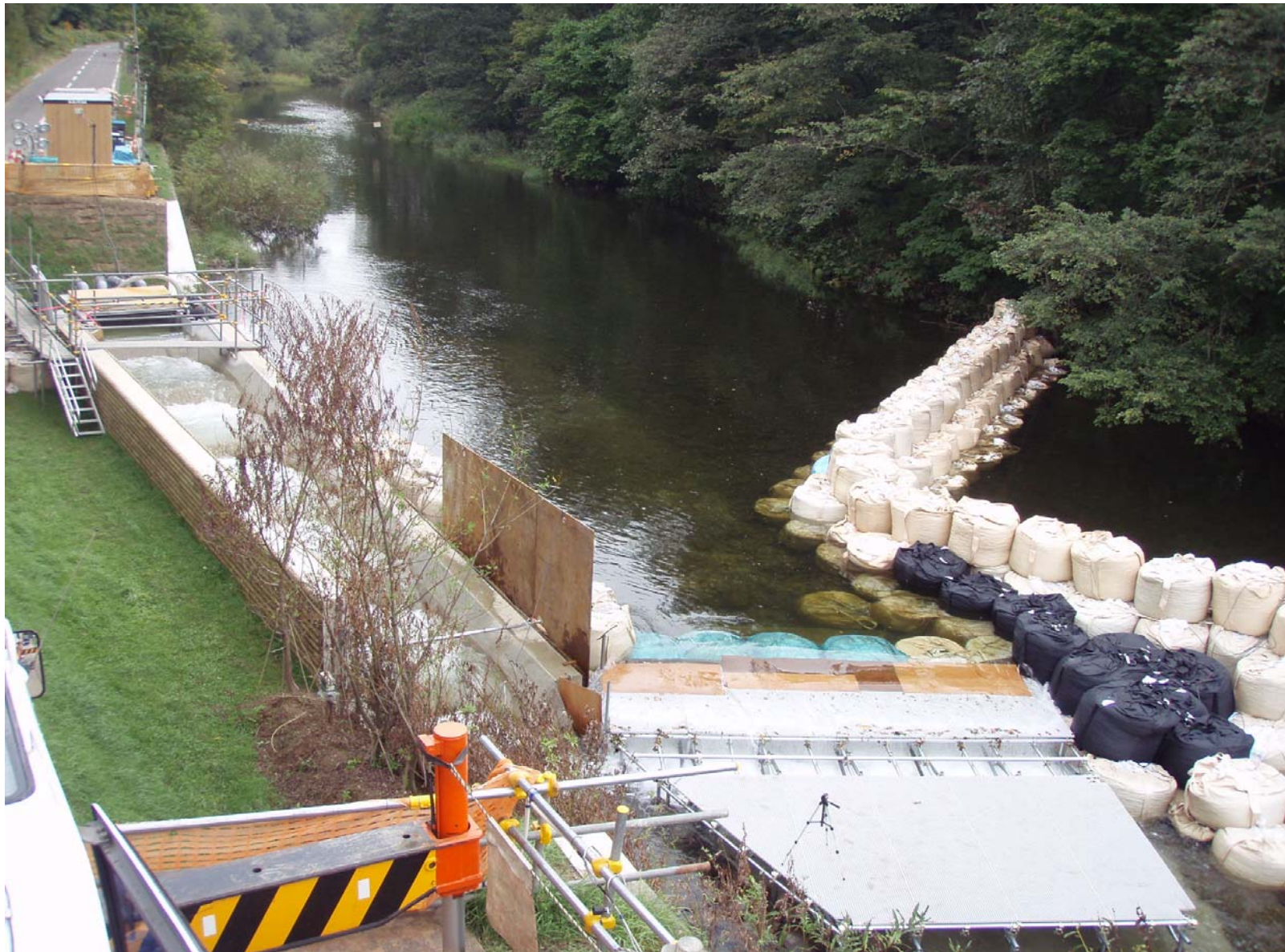
調査用魚道全景（下流から上流をのぞむ）
