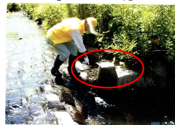
魚道部の土砂埋塞状況
