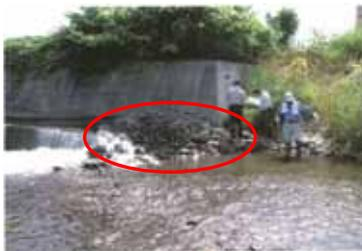
魚道入口部の土砂堆積状況
