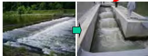
風連20線堰堤(魚道新設)
