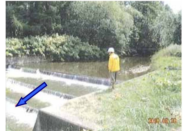
魚道(頭首工)の点検状況
