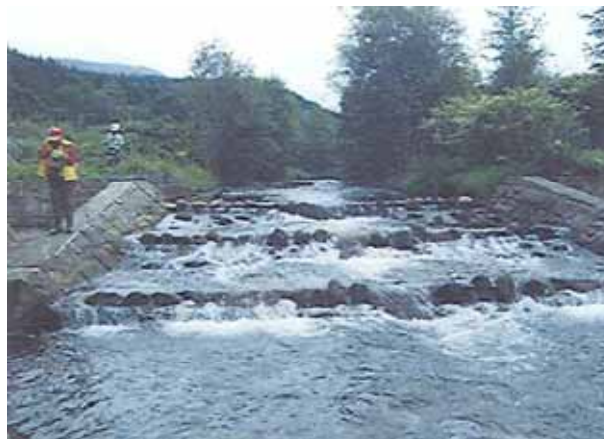
魚道(6号落差工)の点検状況
