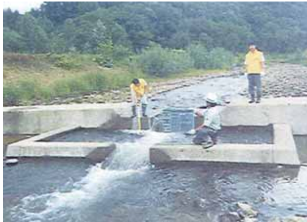
魚道(27号落差工)の点検状況
