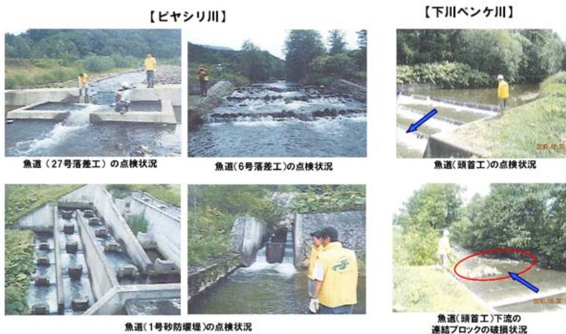
写真-7 NPO 法人天塩川リバーネット 21 による魚道点検状況（平成 22 年度）
