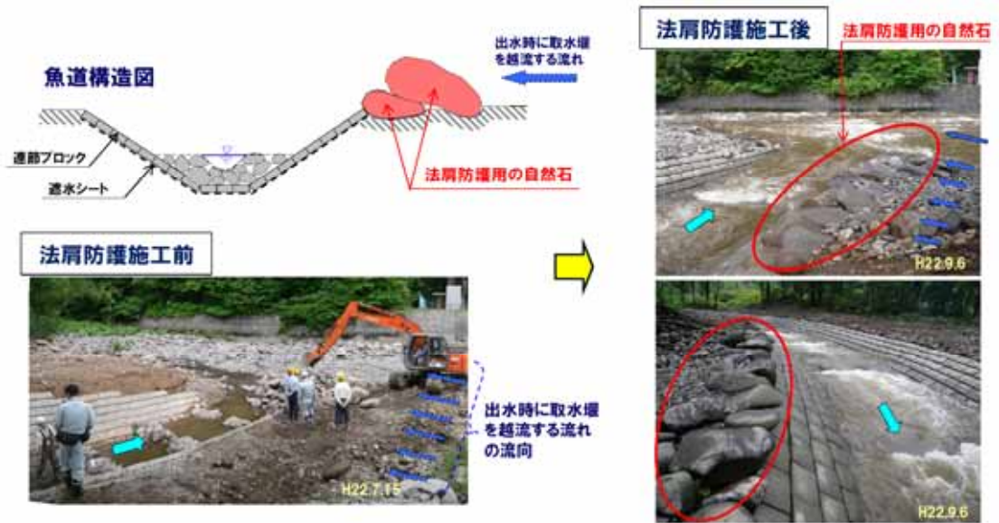
図-25 魚道下流側の法肩保護
