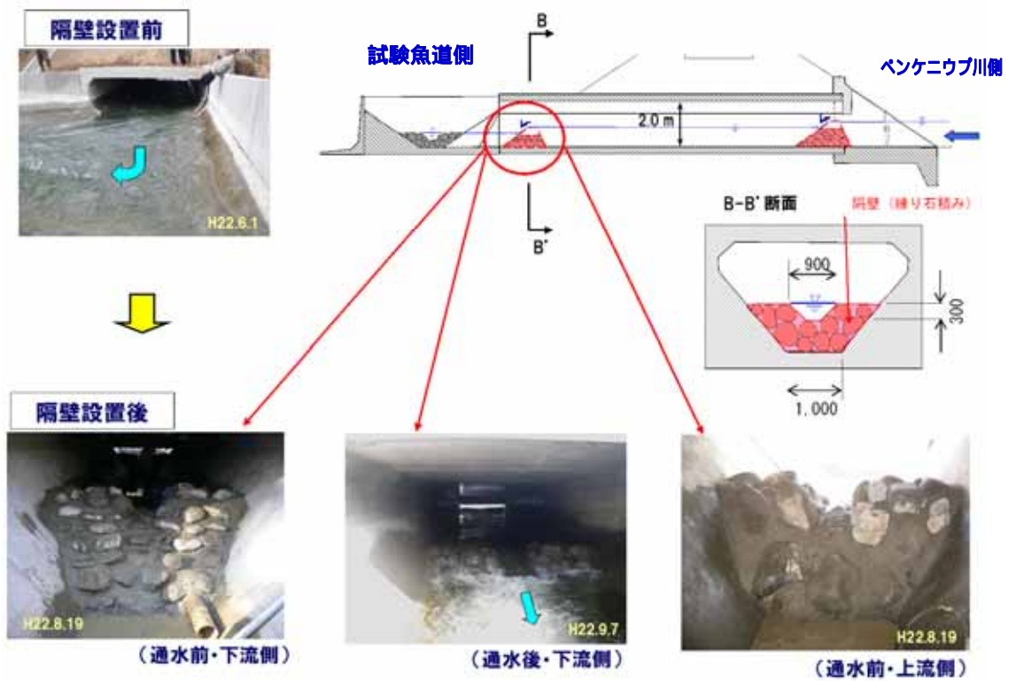
図-24 魚道上流側の改善状況(2)
