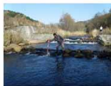
魚道(5号落差工)の点検状況
