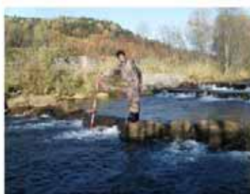
魚道(4号落差工)の点検状況
