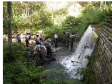
七線沢川支川の右の沢川床固工現地協議
