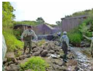
天塩川支川落差工現地協議
