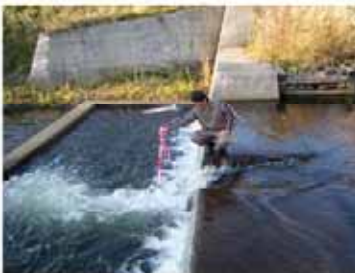
魚道(15号落差工)の点検状況
