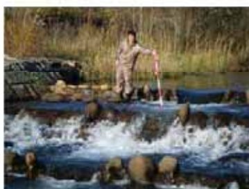
魚道(10号落差工)の点検状況
