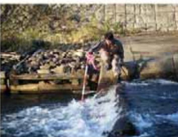
魚道(12号落差工)の点検状況
