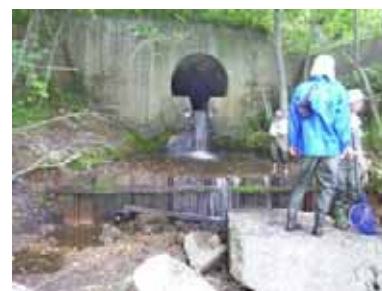
天塩川支川落差工現地協議
