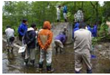
物満内川既存魚道の上流堆砂対策、魚道改善現地協議
