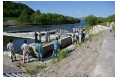
天塩川風連 20 線堰堤の状況確認
