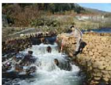
魚道(2号落差工)の点検状況
