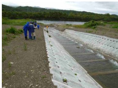
アラキの川階段式魚道の流況確認
