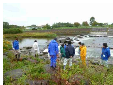
天塩川帯工魚道(右岸)の流況確認
