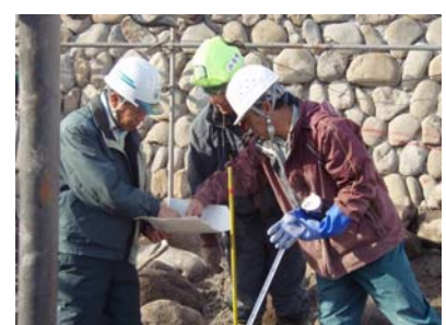
頭首工魚道石組み 現地施工打合せ
