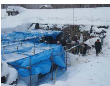
下川ペンケ川頭首工魚道 石組み現地全景
