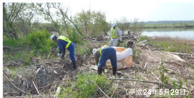
処理作業状況
