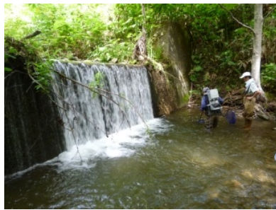
アラキの川(上流)床止工の 遡上改善現地協議
