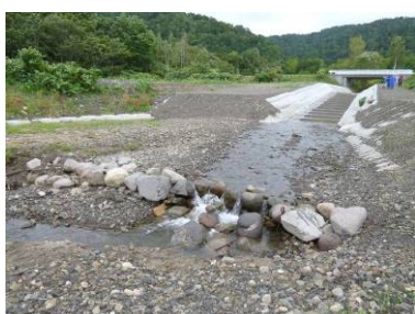
アラキの川魚道下流部の減勢工 (天塩川合流部)の状況確認
