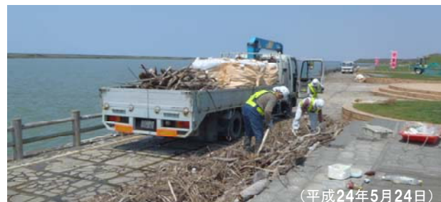
処理作業状況
