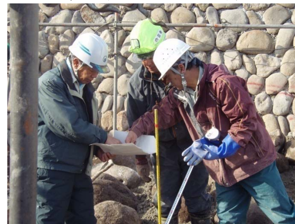
頭首工魚道石組み 現地施工打合せ状況
