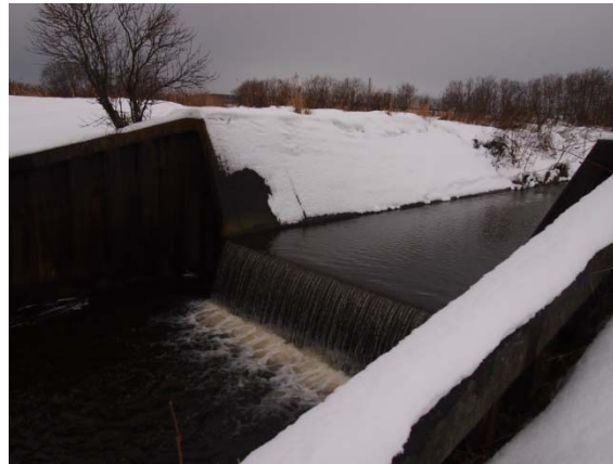
円山ウブシ川の落差工の流況確認
