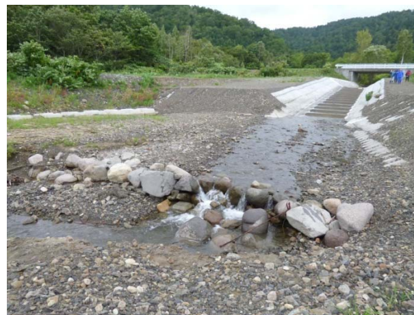
アラキの川減勢工の状況確認
