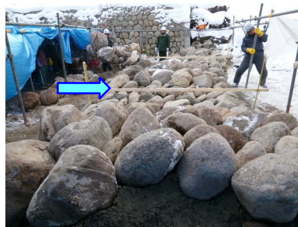
頭首工魚道下流端部 石組み施工状況
