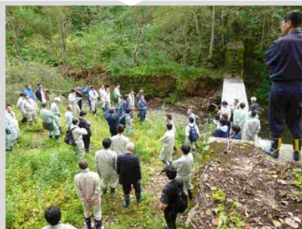
高広川床固工の切下げ
