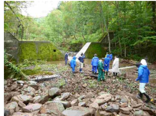
ペンケニウブ川支川高広 川床固工の切下げ確認
