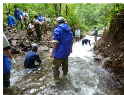
11 線沢川のペンケニウブ川合流 部落差における石組み改善状況
