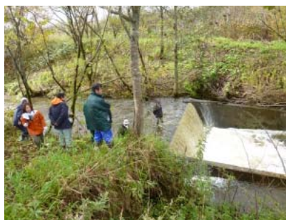
コクネツ川落差工の流況確認
