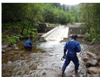
9線沢川魚道の流況確認 と魚類調査状況
