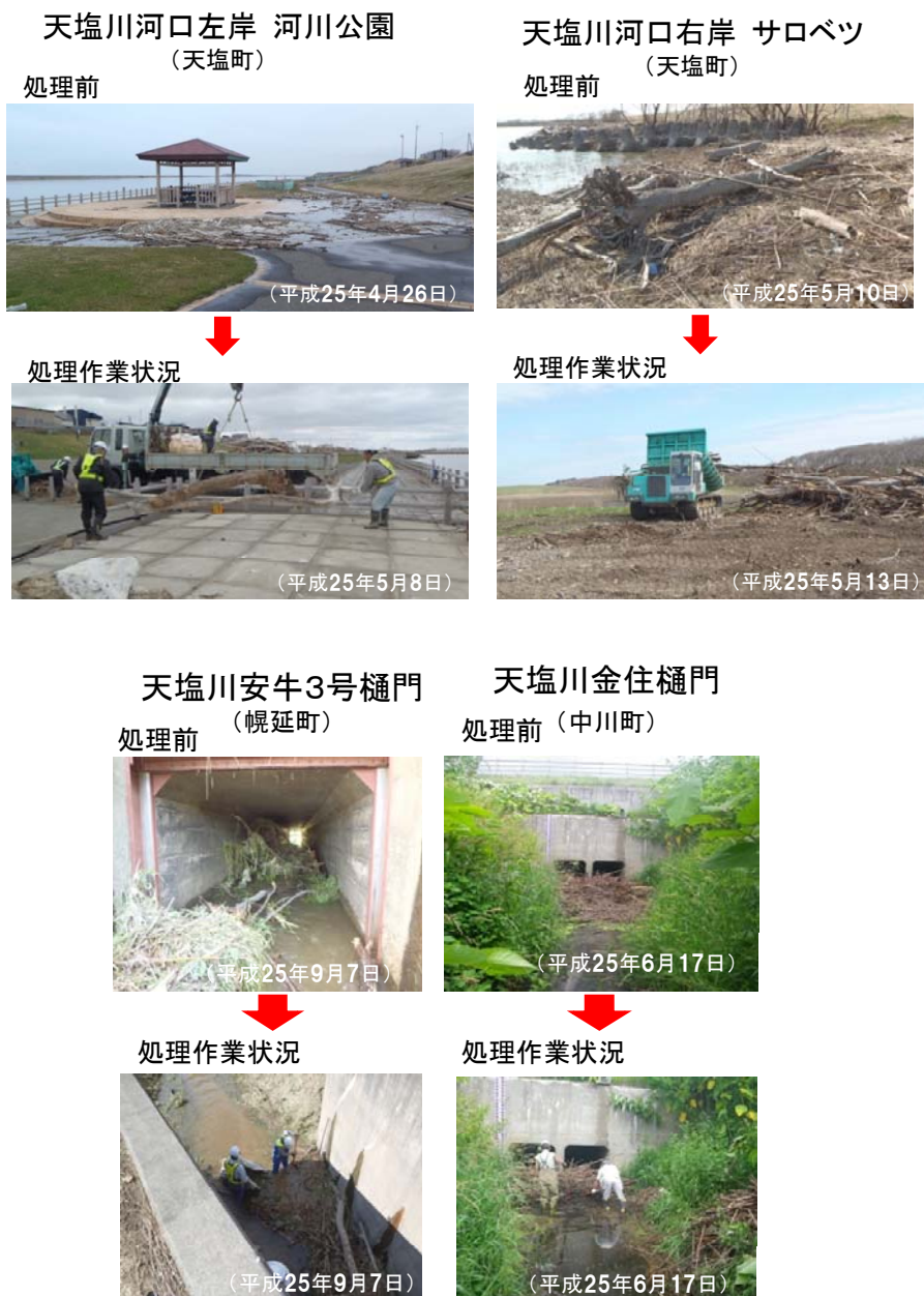
写真- 13 流木・塵芥処理の状況（処理前、処理作業中）
