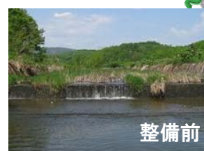
九線(南8線) 川1号落差工 魚道整備(H26.3予定)
