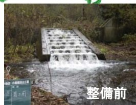
パンモンポ沢川 No1床固工 魚道整備(H25.11)
