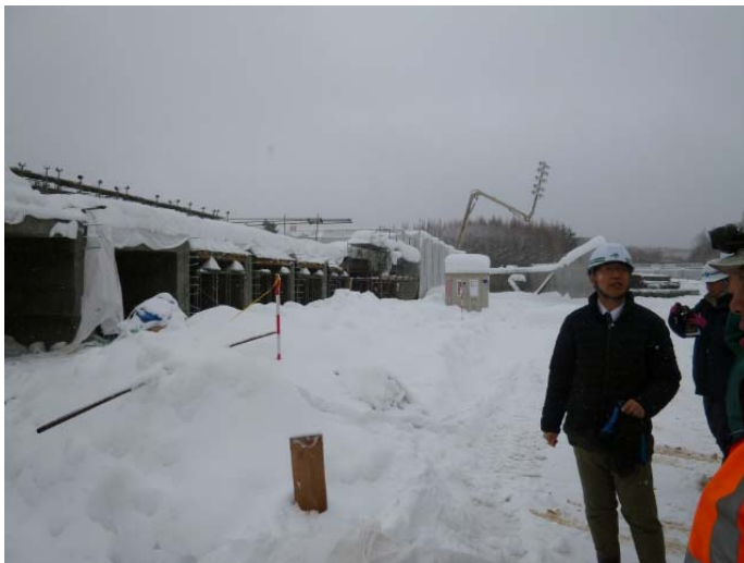
事業進捗状況確認
