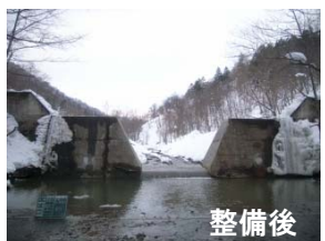
琴平川(アユマナイ川) No1床固工 切り下げ(H26.2)
