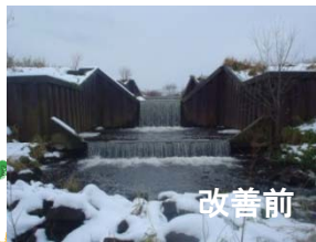
円山ウブシ川 落差工 魚道整備(H26.2)
