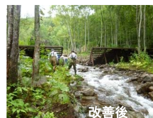
十一線沢川No.1床固工 切り下げ(H25.8)
