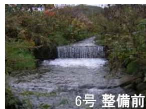
ポントフトナイ川落差工 (5カ所) 魚道整備(H26.3予定)
