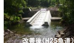
九線沢川No.1床固工 魚道設置(H25.8)
