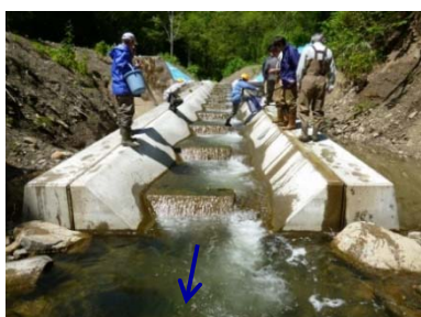
アラキの川 No1 床固工魚道の流況確認
