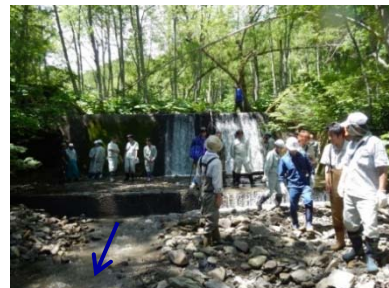
アラキの川 No3 床固工の現地確認
