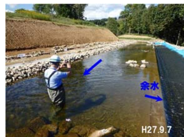
[バイパス水路] 試験余水吐施設分水状況の確認
