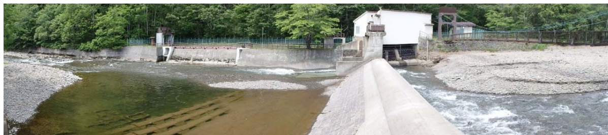
写真-1 取水堰ゲート解放時における流況
