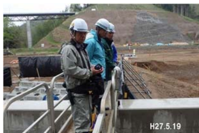
[仮排水路] 下流部の流況確認
