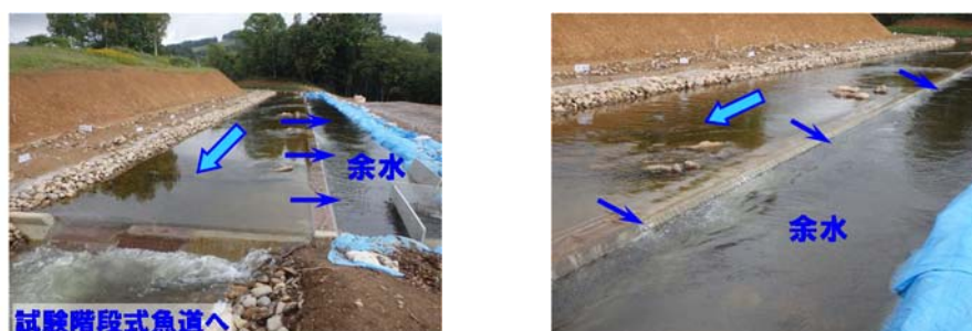
写真-17 試験余水吐（流量調整施設）の横越流状況
