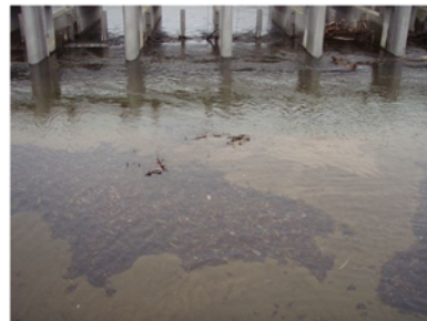
H27夏期出水による土砂堆積状況
