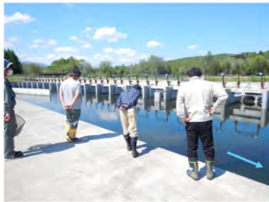
(6/1本川との接続箇所) スモルト降下状況等確認
