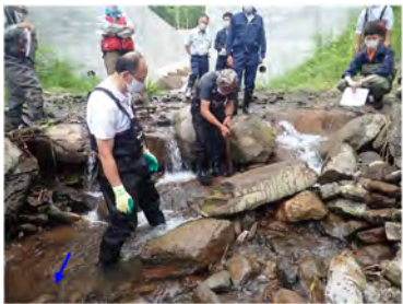
右の沢川 魚道間落差箇所の 石組み接合部の修正作業状況
