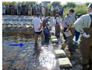
ピヤシリ川 (No3 魚道) 魚道減勢工下流端の改善指導
