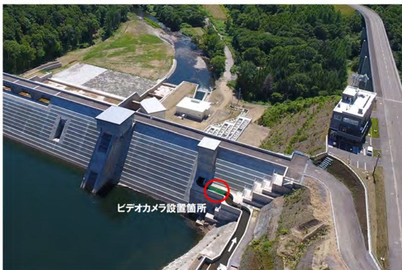
写真- 14 遡上解析ビデオカメラ設置状況
