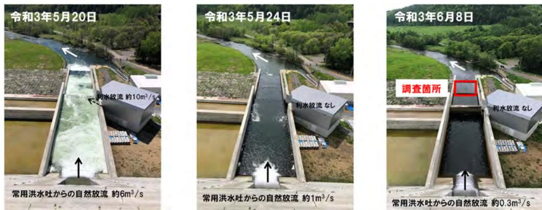
写真-14 サンプルダム常用洪水吐からの放流状況（令和3年）
