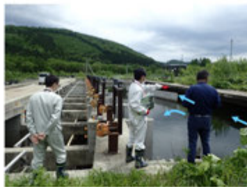
(6/2) 本川との接続箇所 施設内流況確認
