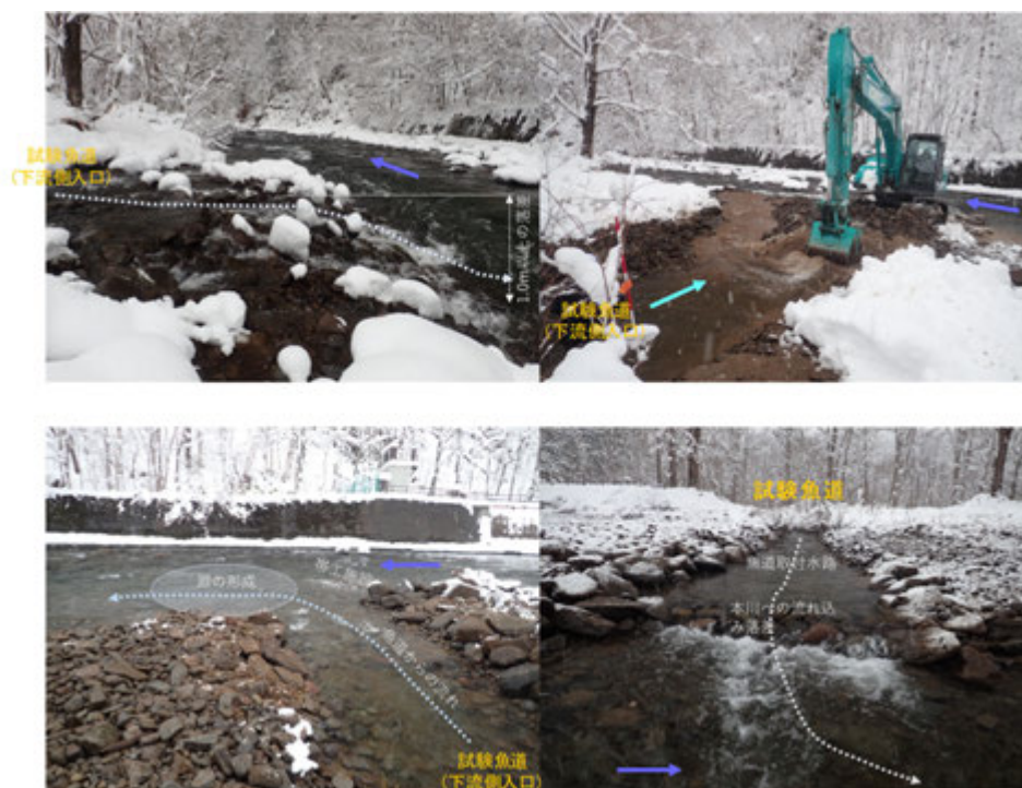
写真-3 魚道水路入口部の土砂堆積による落差解消工事中と施工後の状況
