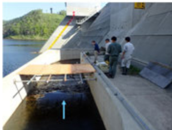
(5/25) ダム堤体直上流(ビデオカメラ箇所) サクラマス遡上調査方法確認
