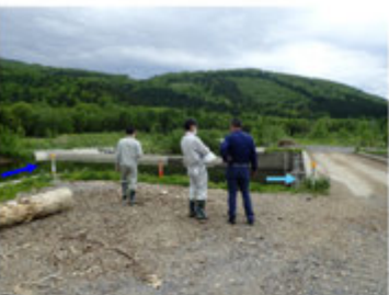
(6/2) 本川との接続箇所 流入部流況確認
