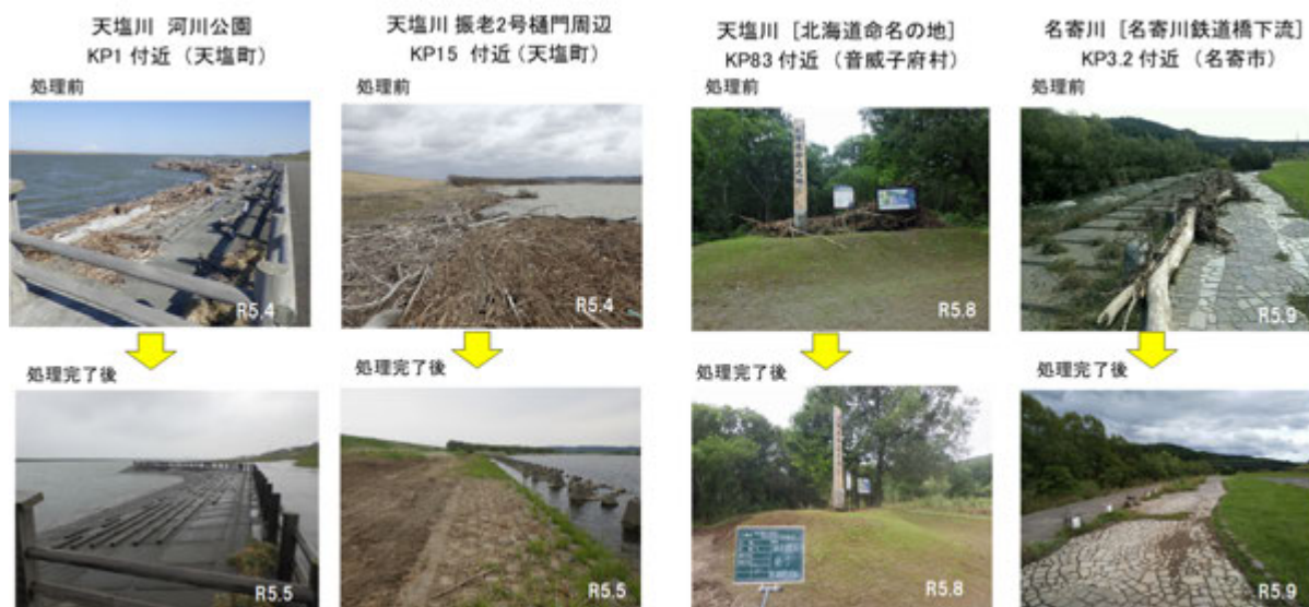
写真- 13 令和5年 融雪出水後の流木・塵芥処理の状況（処理前、処理完了後）
