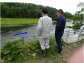
(6/2) ダム堤体下流 流況確認
