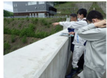
(6/2) ダム堤体 階段式魚道確認
