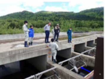
(6/5) 本川との接続箇所 ドラムスクリーン稼働状況確認
