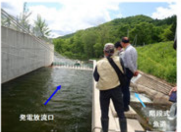
(6/5) ダム堤体下流 発電放流口の下流端スクリーンと流況確認
