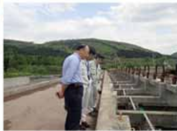
(5/21) 安田委員 本川接続箇所ドラムスクリーン稼働状況確認
