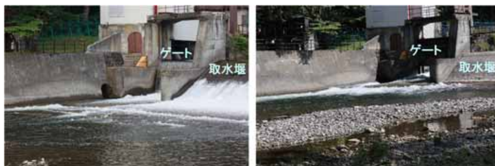
（取水堰からの越流状況）
