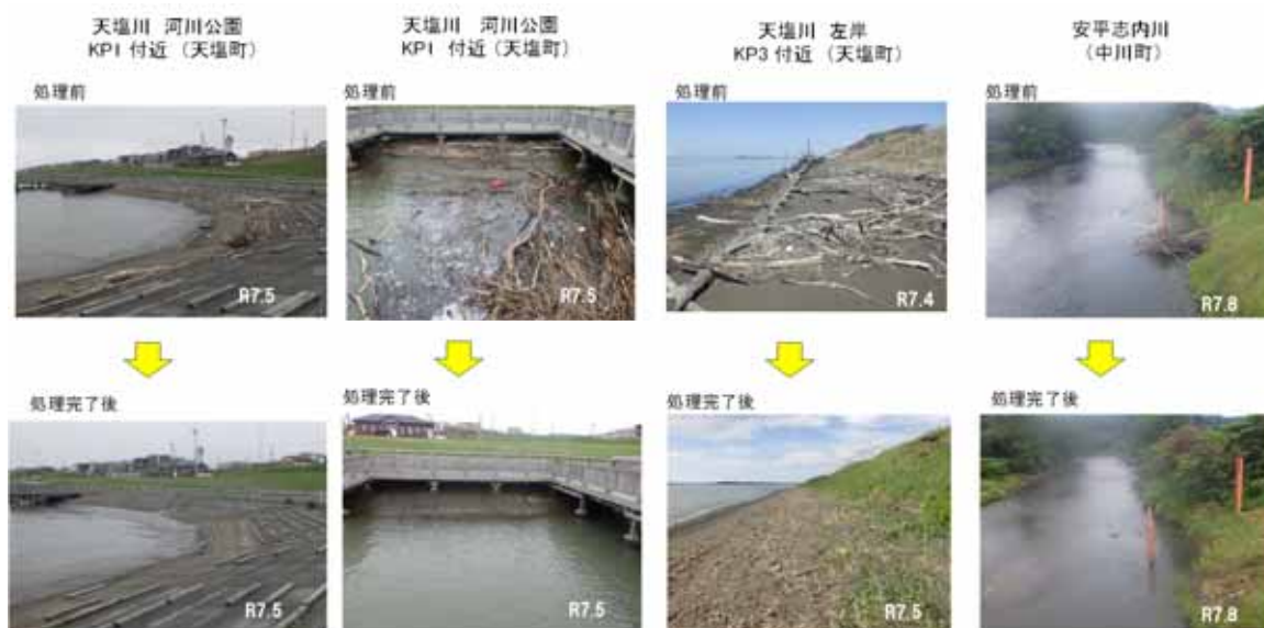
写真- 11 令和7年 融雪出水後の流木・塵芥処理の状況（処理前、処理完了後）
