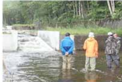
既設床固工魚道設置箇所 魚道の状況
