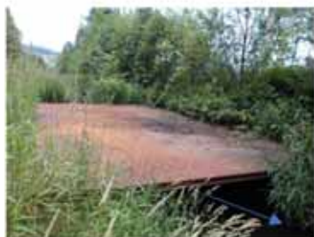
バイパス水路 生息環境改善状況（敷鉄板）
