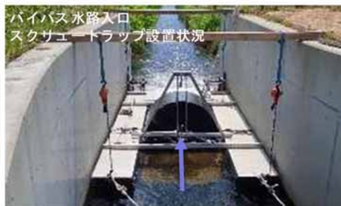
写真-17 スクリュートラップ設置状況
