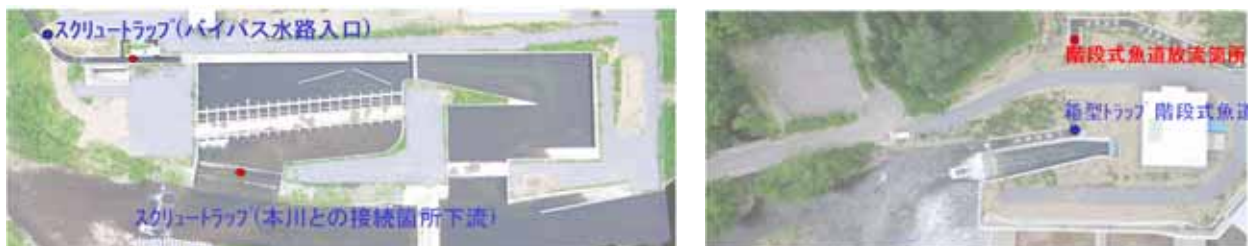
写真- 15 トラップ設置箇所
