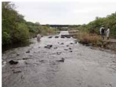
落差工魚道設置箇所
