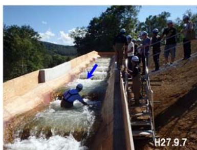
[試験階段式魚道] 魚道部の流況確認
