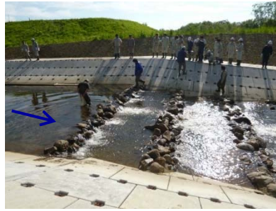
ピヤシリ川護岸落差部の 魚道の流況等確認
