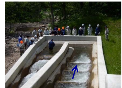
九線沢川 No3 床固工魚道の流況確認
