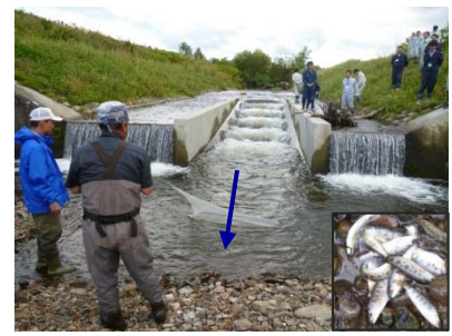
パンケヌカナンブ川(1号落差工) 魚道の流況・生息魚類確認
