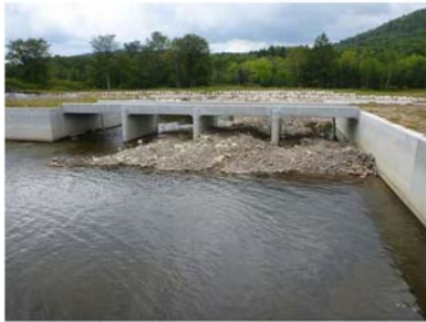
H26.8出水による土砂堆積状況
