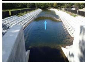
仮排水路下流の状況
