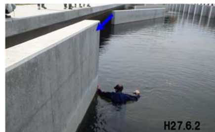
[本川との接続箇所] 施設内の流況確認
