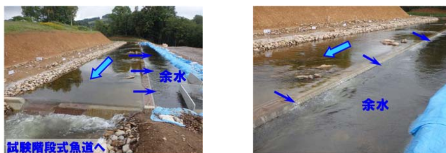
写真-17 試験余水吐（流量調整施設）の横越流状況
