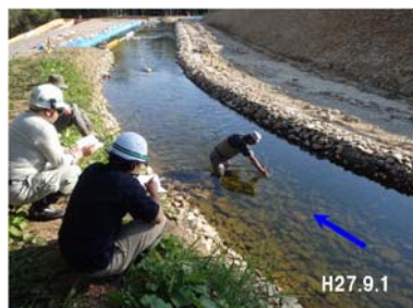
[バイパス水路] バイパス水路内流況の確認
