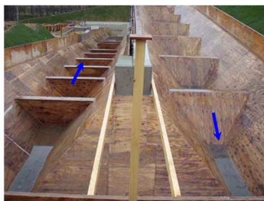
図- 31 プール部の土砂堆積有無の状況（土砂堆積なし）
