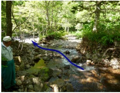
十一線沢川の本川合流部の 河道状況確認
