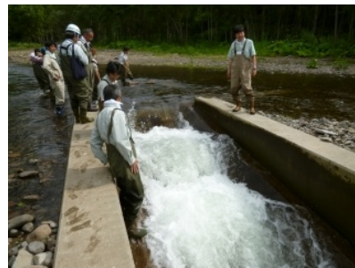
ペンケニウプ川支川七線沢川 床固工魚道の流量調節についての 現地協議
