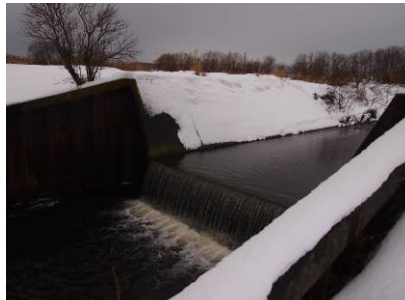
円山ウブシ川の落差工の流況確認
