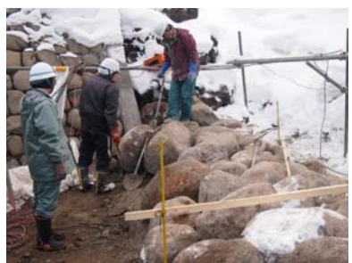
頭首工魚道既設護岸部 石組み現地指導
