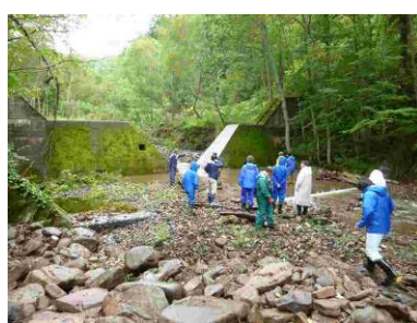
ペンケニウプ川支川高広川 床固工の切下げ確認
