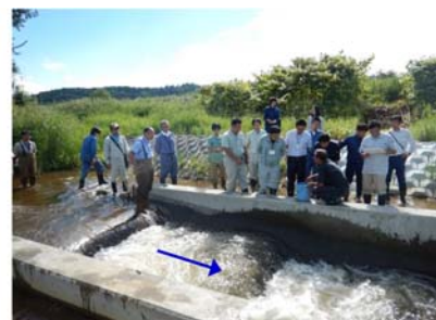
コクネップ川魚道の現地確認（No5 落差工魚道）
