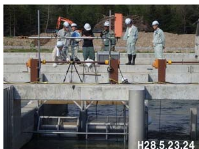
[本川との接続箇所] 施設内流況・スクリーン稼働状況確認
