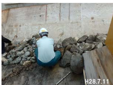
[試験階段式魚道] 折返し部の石組み指導
