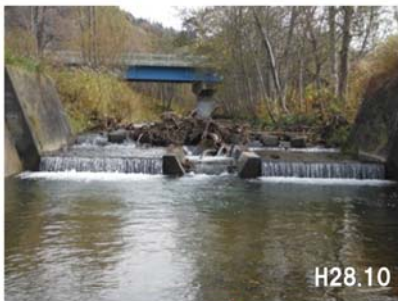
琴平川床止め工魚道部 (中川町)
