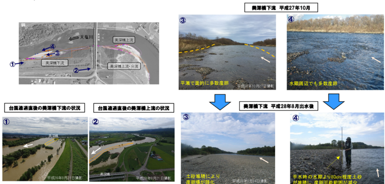
写真-22 美深橋周辺における出水状況 (H28 年 8 月) と出水後の河道状況
