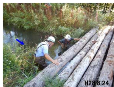
[バイパス水路] バイパス水路流況確認
