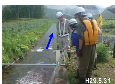
[本川との接続箇所] バイパス水路流況確認
