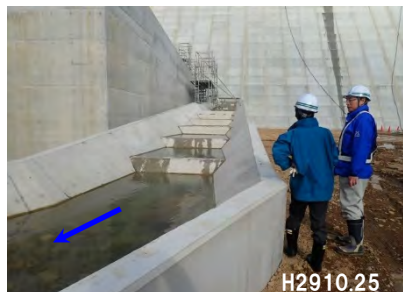
[階段式魚道] 施設確認
