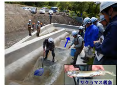
アラキの川 (No3 床固工魚道) 魚道の流況・生息魚類確認
