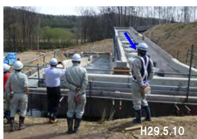
[試験階段式魚道] 通水状況確認
