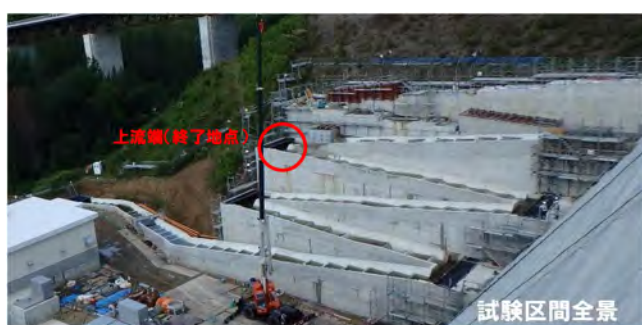
写真- 16 階段式魚道の整備状況
