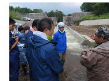
新生川（2 号砂防えん堤） 魚道の機能確認・指導状況
