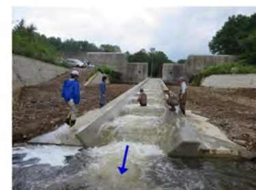
新生川（2 号砂防えん堤） 魚道内の流況確認
