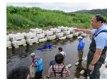
ペンケルペシュペ川魚道下流端と 現況河道とのすり付け形状の指導
