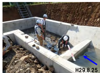
[階段式魚道] 折返し部石組み指導
