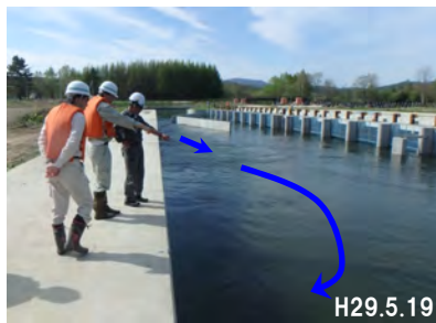
[本川との接続箇所] 施設内流況確認
