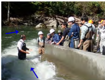
物満内川 (No2 床固工魚道増設) 魚道の流況確認
