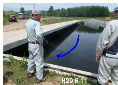
[本川との接続箇所] 施設内の流況確認
