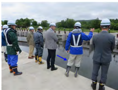
流木除去施設の現地確認
