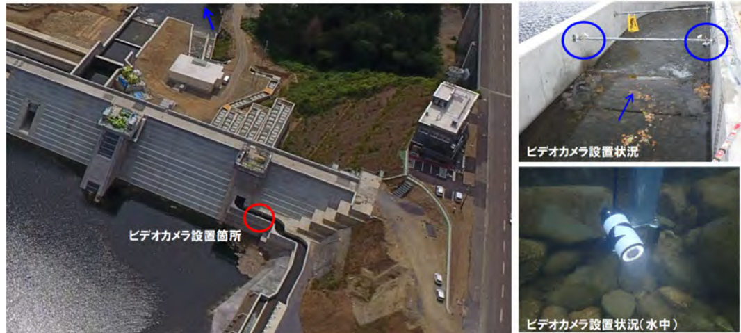
写真- 19 ビデオカメラ設置状況
