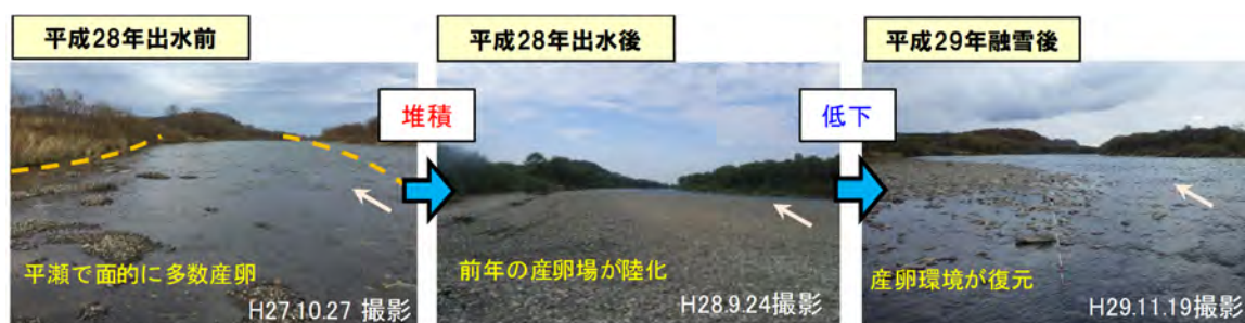
写真- 25 美深橋下流における平成 28 年 8 月出水前後の現地状況
