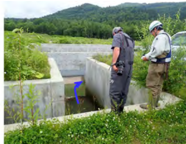
(7/10本川との接続箇所)流況確認
