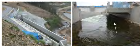
堤体上流余水吐全景
