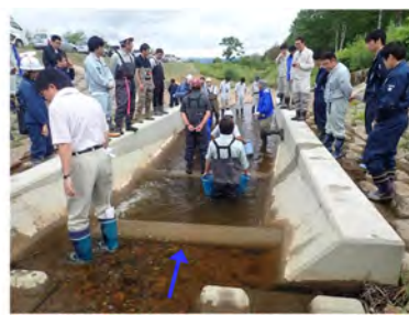
有利里川 (第 2 号落差工魚道) 魚道の評価・改善指導
