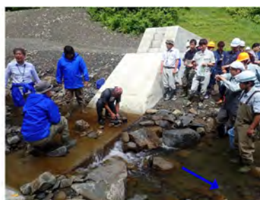
アラキの川 (No6 複断面床固工) 石組みによる天端流況改善の実験
