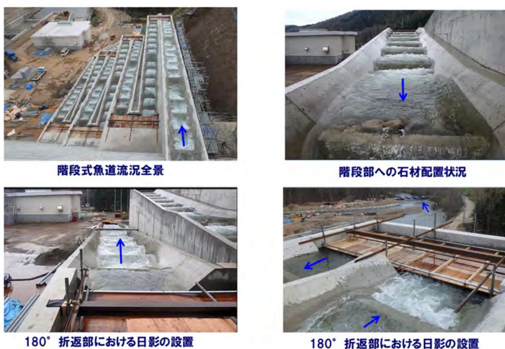
写真- 14 階段式魚道の改良状況
