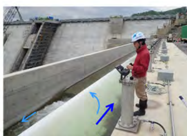
(5/30堤体上流余水吐) 流況・スモルト降下状況確認
