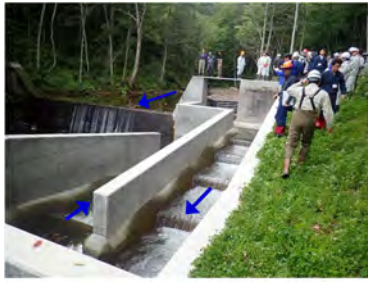
モサナル川(第1号谷止工魚道) 魚道の流況等確認
