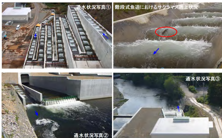
写真- 16 階段式魚道を含む堤体下流部の状況
