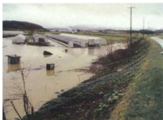
名寄川上名寄16線樋門地先浸水状況 平成18年5月11日午前撮影
