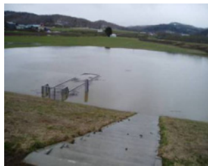
天塩川紋穂内地区浸水状況 平成18年5月11日午前撮影
