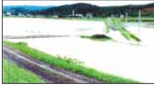
天塩川 音威子府村麓島地区の氾濫状況
