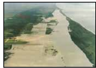
天塩川左岸 冠水した 天塩市街上流の農地 昭和 50 年 9 月洪水
