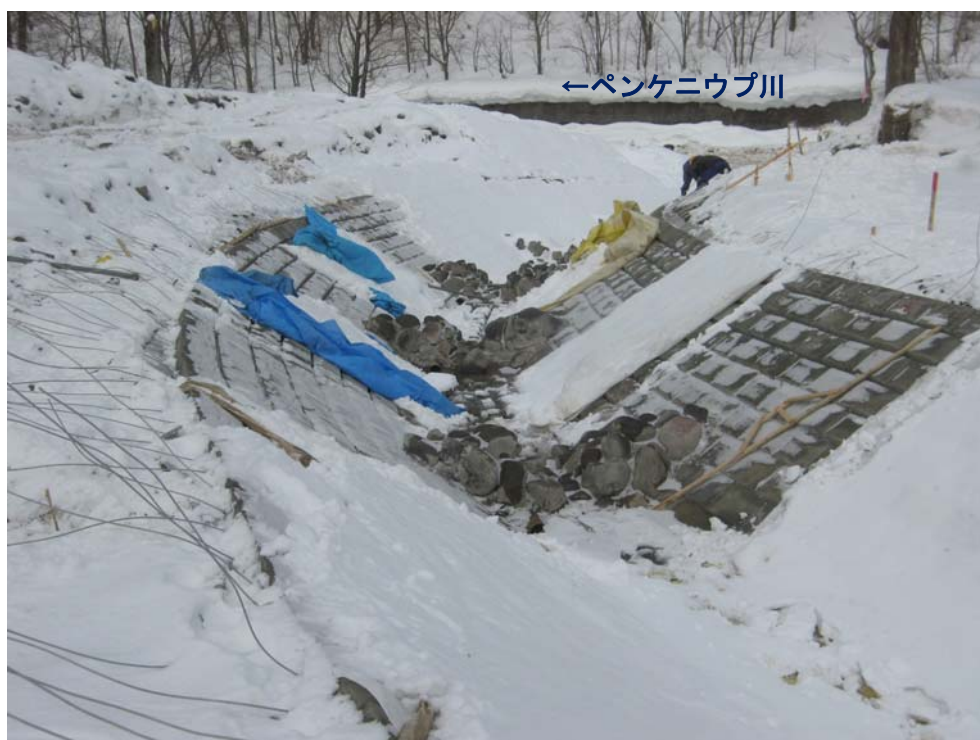
下流側の魚道水路工と石積み隔壁（施工中）
