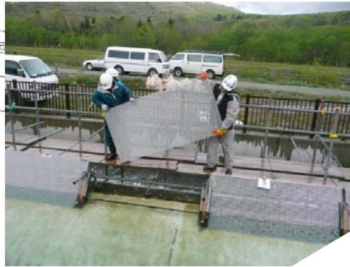
幅2m × 高さ1mのスクリーンを計15枚設置
