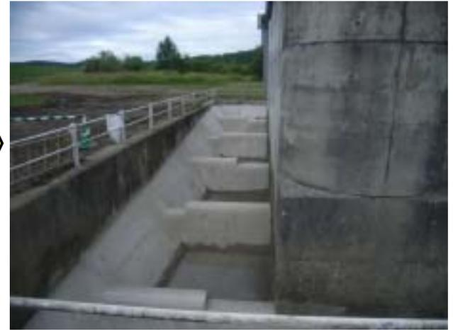
階段部(傾斜側壁、台形型隔壁)
