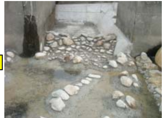
玉石積み隔壁 (下流端部)
