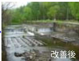
新生川落差工 (魚道新設)
