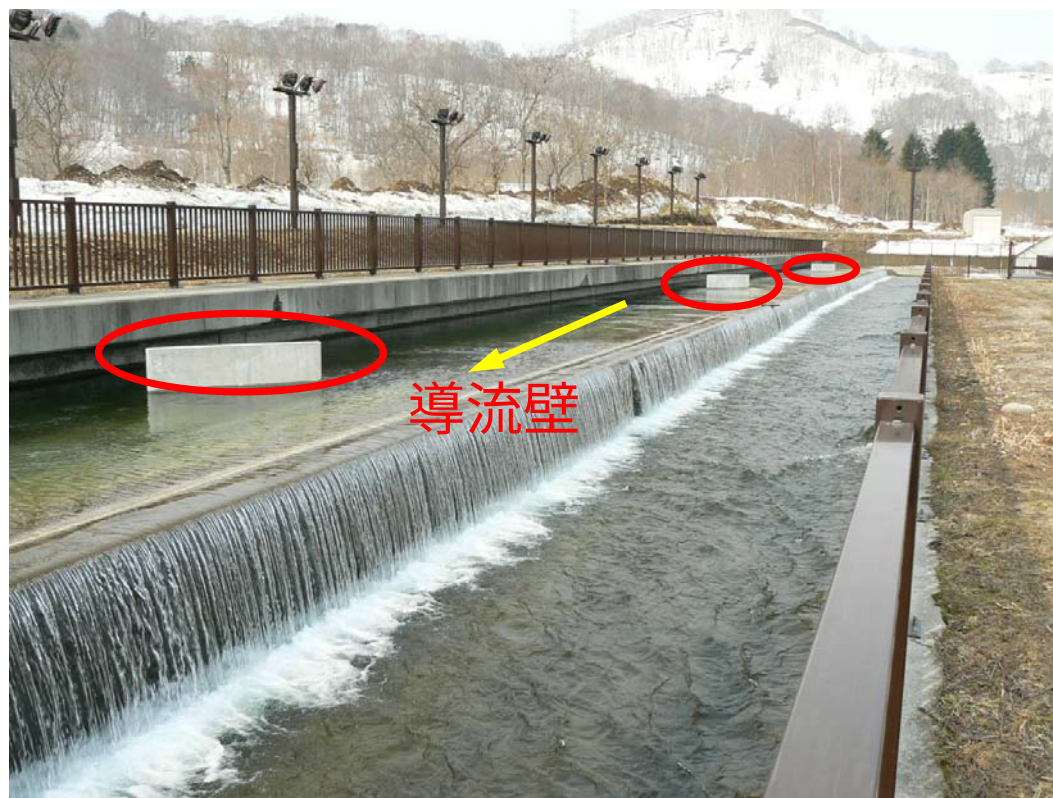
美利河ダム分水施設
