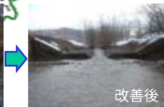
銀川落差工 (魚道新設)
