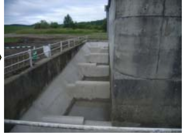
階段部 (傾斜側壁、台形型隔壁)
