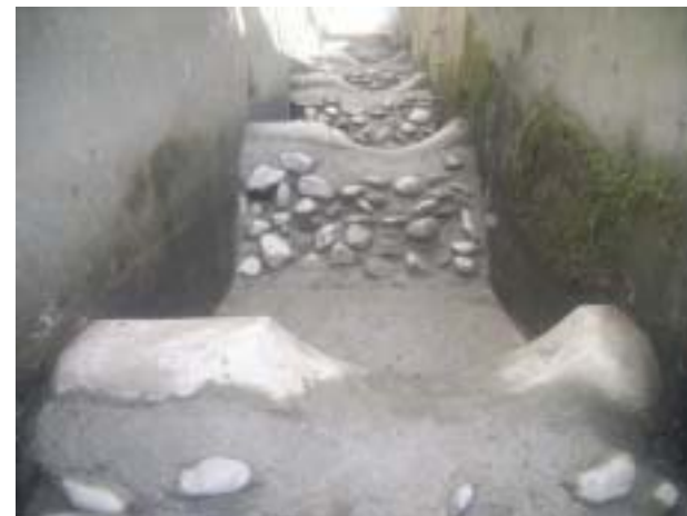
改善後 (玉石積みによるはく離の解消)
