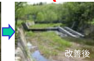
トヨナイ川落差工 (魚道新設)
