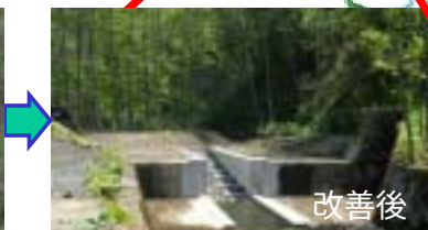
銅蘭川落差工 (魚道新設)
