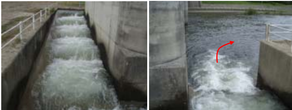
魚道内の状況
