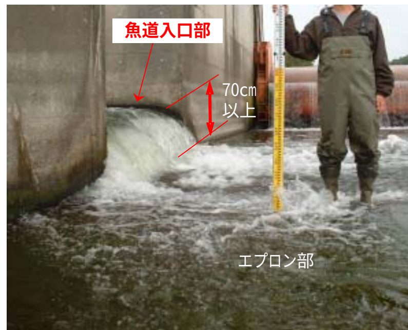
魚道入口部(真勲別頭首工)
