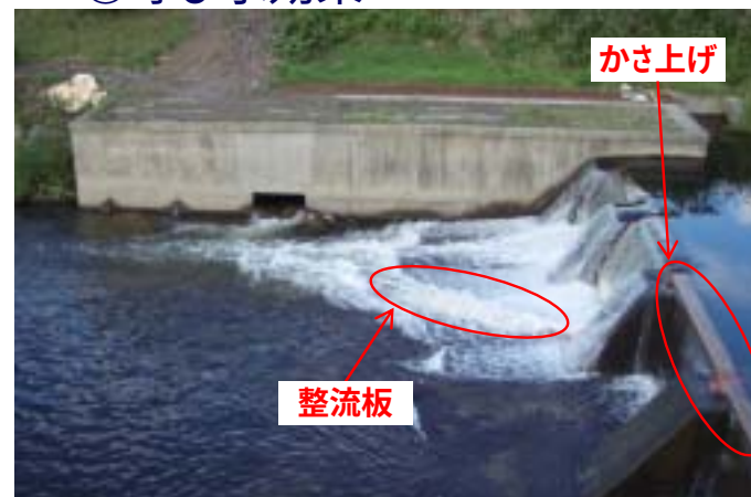
整流板と固定堰のかさ上げ (呼び水効果の創出)
