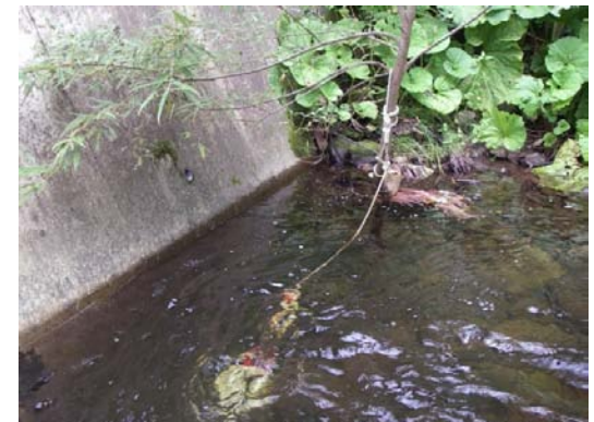
▲受信機設置状況
