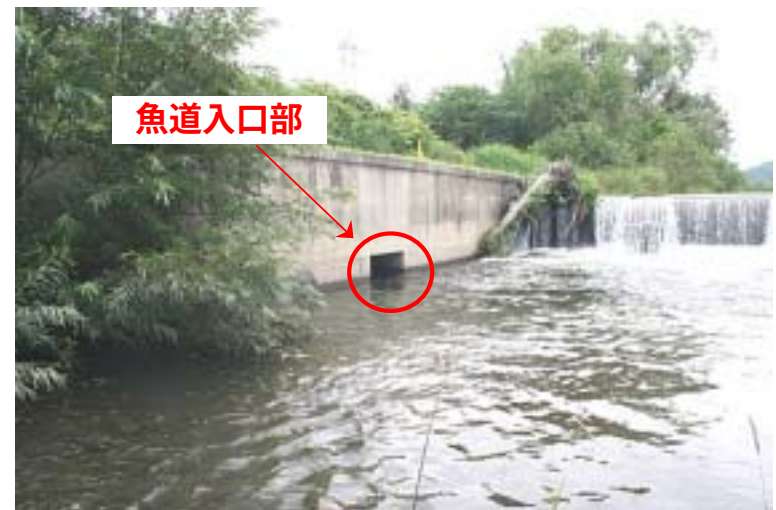
魚道入口部(上名寄頭首工)
