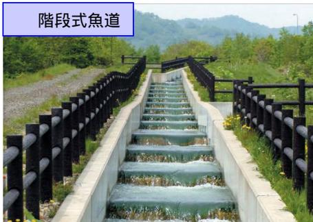
階段式魚道は、越流隔壁を半円型に切り欠いた型式を採用し、大型魚類の遡上に配慮。潜孔を設け、底生魚の遡上に配慮した構造です。
