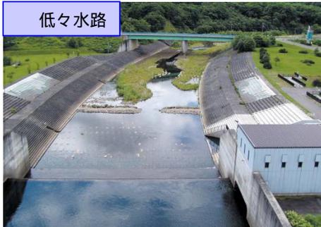
ダム直下から下流への360m区間は、魚の遡上を確保するために河道を部分的に掘り下げた低々水路を設置しています。形状は自然の川に近づけるため蛇行させています。
