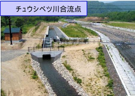
取水堰と余水吐き施設は魚道への流量の安定供給
